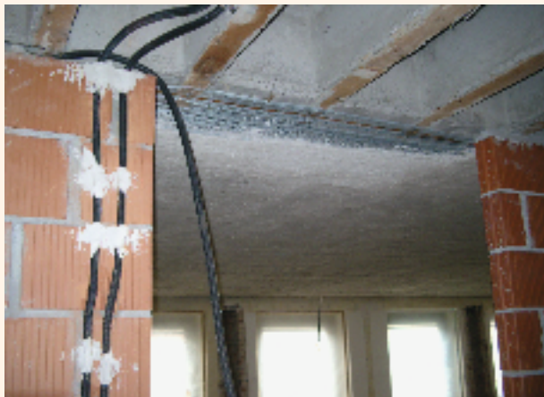
1 Brandschutz mit hängender Drahtdecke nach DIN.
