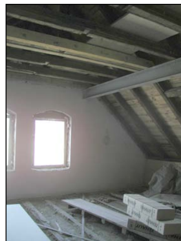
Bild 5: Raum im Dachgeschoss während der Sanierung
