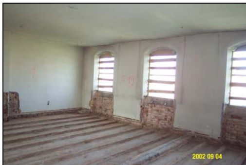
Bild 3: Raum im 1. Obergeschoss während der Schadstoffsanierung
