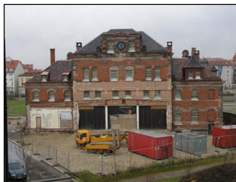
Bild 2: Gasthaus- und Verwaltungsgebäude vor der Sanierung (Südfassade)
