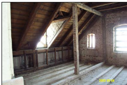
Bild 4: Raum im Dachgeschoss während der Schadstoffsanierung
