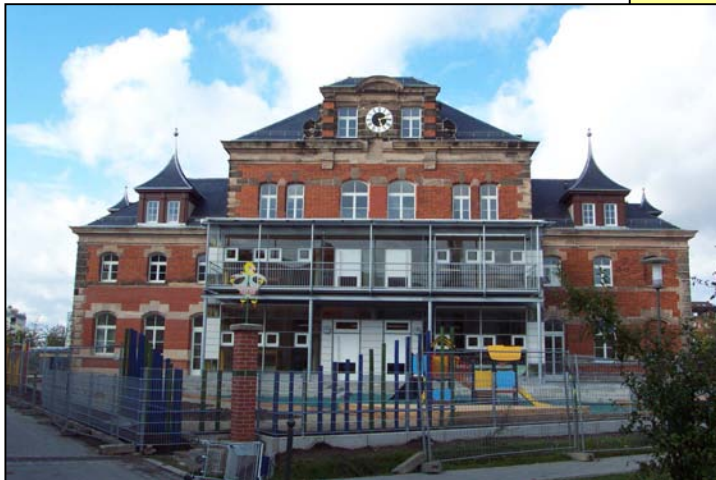
Bild 1: Kindertagesstätte Philipp-Koerber-Weg 2 nach Sanierung (ehemals Schlachthofstraße 7)
