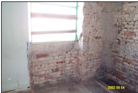
Bild 6: Außenwandecke und Fensterbereich Erdgeschoss während der Sanierung
